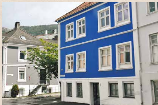
Ny Sandviksvei 43 (det blå murhuset) i Bergen der familien Aas bodde etter L.C. Aas' fengselsopphold. Foto: GAS
